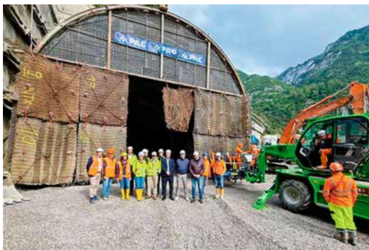
Tecnici e amministratori davanti all'entrata della nuova galleria
