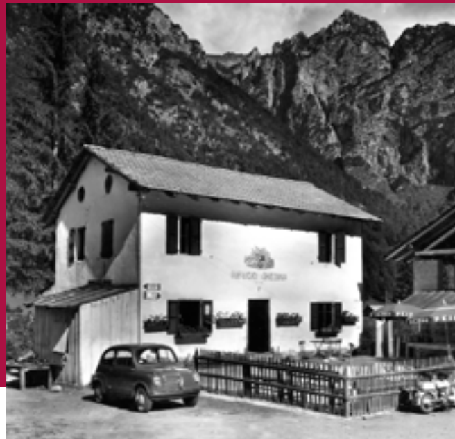
Il rifugio Ghedina con fili elettrici 1956
