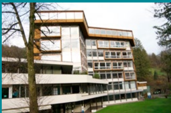
Lo stabilimento termale che attende una profonda ristrutturazione
