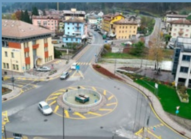
Prendono forma la rotonda e il nuovo campanile della chiesa di Ponte Arche (foto Gabriella Maines)
