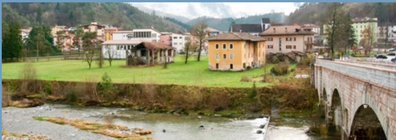
L'area Alberti a Ponte Arche
