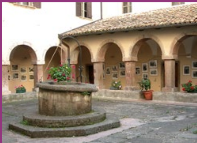
L'attuale struttura del convento di Campo Lomase (foto F. Brunelli)
