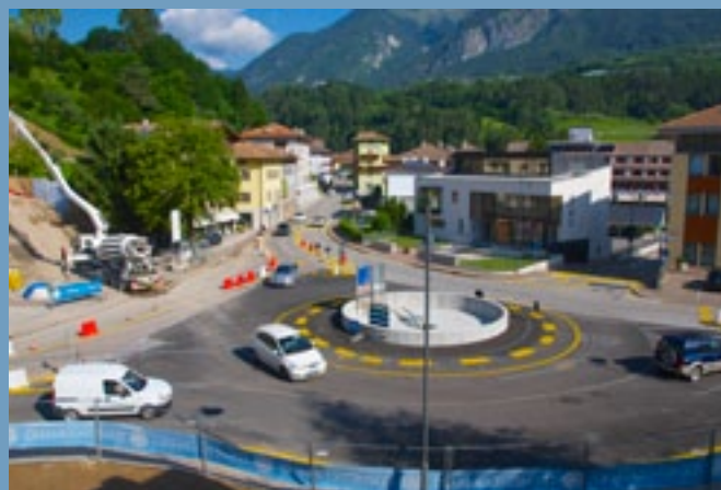
La nuova rotatoria di Ponte Arche, in fase completamento (foto F. Brunelli)
