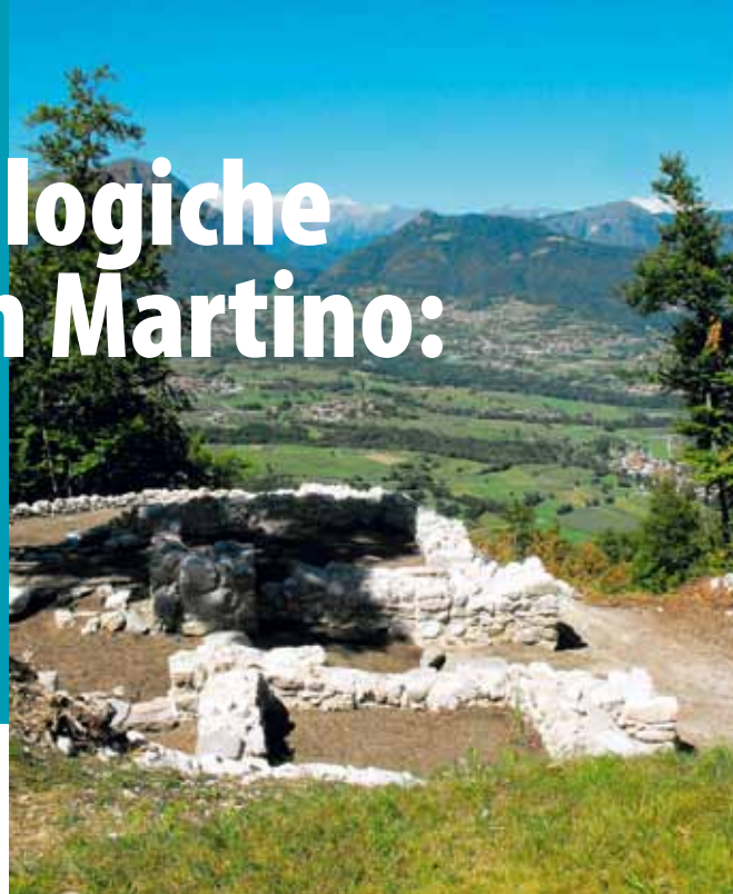
La linea delle strutture addossate a tratto Nord della cinta dominante il paesaggio al termine della sistemazione e del ripristino.
