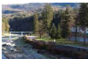
ARGINE MURATO con percorso adiacente a siepe
