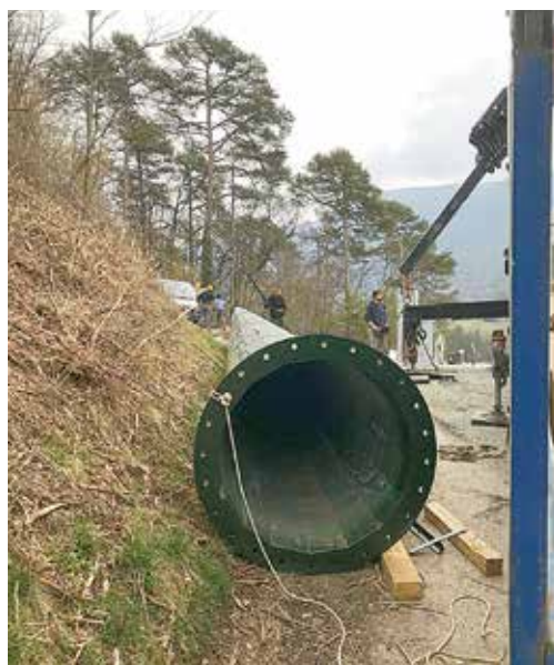
I lavori per la posa in opera dell'antenna
