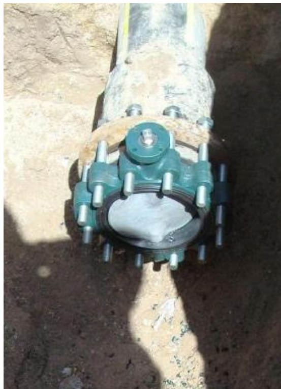
Figura 2: valvola a farfalla interrata
